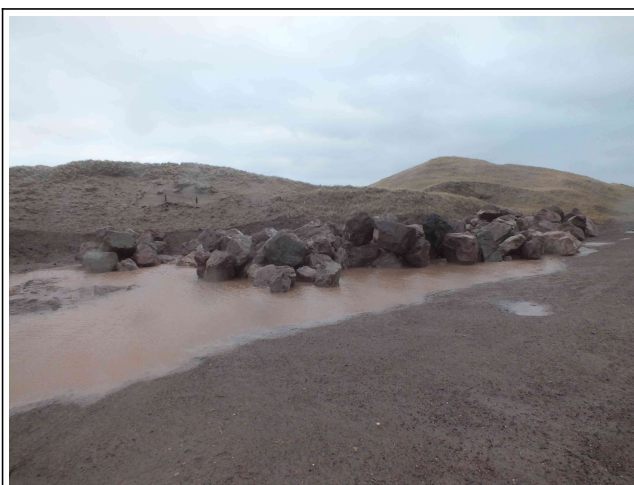
Stockage des nouveaux enrochements
