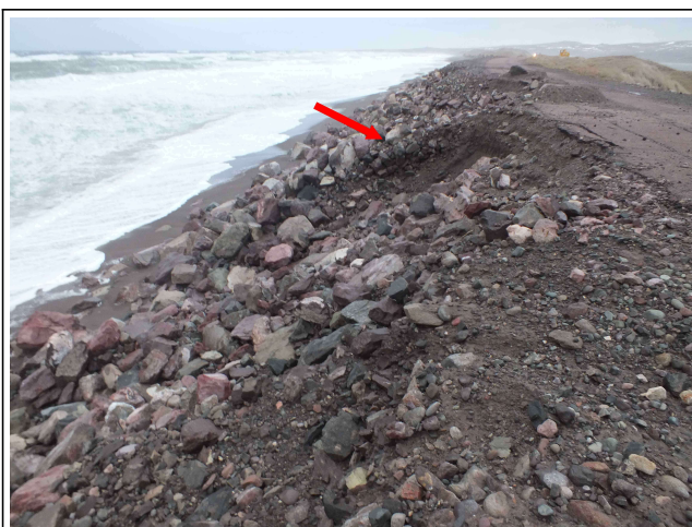
Érosion de la tête de talus entre les effondrements amont et central
