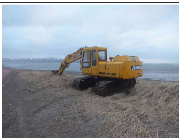
Pelleteuse mobilisée sur le chantier
